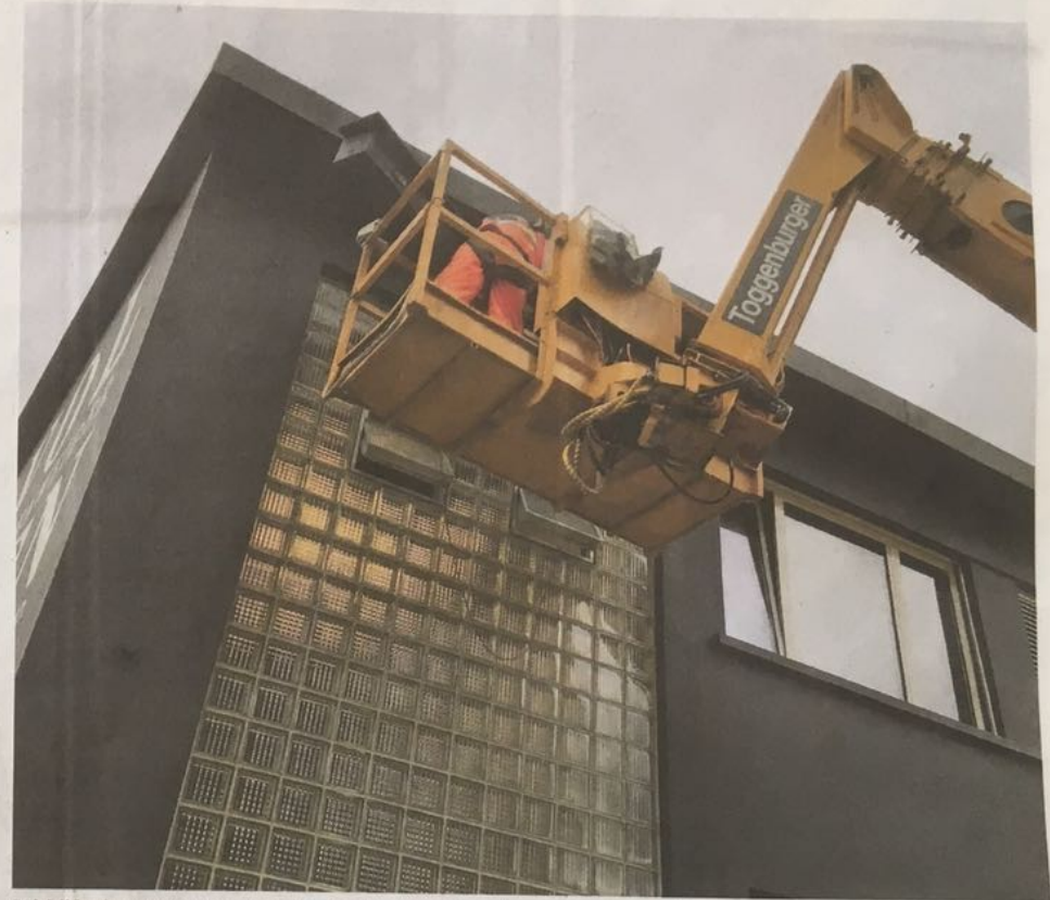
Mithilfe einer Hebebühne montierten die Vogelfreunde gestern Morgen die Nistkästen.
